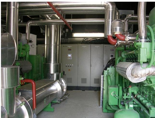
Das gereinigte Biogas wird zu den Gasmotoren geführt und in zwei BHKWs in elektrische und thermische Energie umgewandelt. Die BHKWs haben eine elektrische Leistung von 500 kW, die produzierte elektrische Energie pro Jahr beträgt ca. 4.350 MWh (ca. 10 % elektrischer Eigenbedarf) und eine thermische Leistung von 535 kW, die produzierte thermische Energie pro Jahr beträgt ca. 5.220 MWh (ca. 15 % thermischer Eigenbedarf). Der Strom wird in das öffentliche Netz eingespeist und
