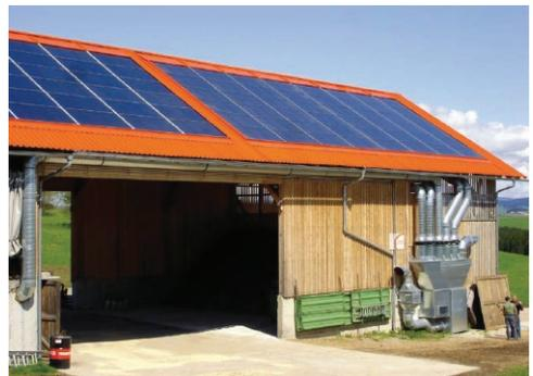
Solare Hackguttrocknung (Cona)
