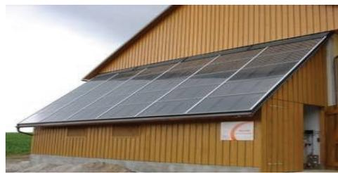
Solarfläche für die Trocknung von Hackgut (Cona)
