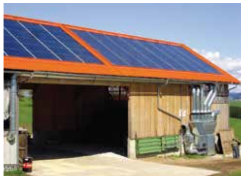
Solarno sušenje lesnih sekancev (Cona)
