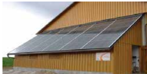
Solarne površine za sušenje sekancev (Cona)
