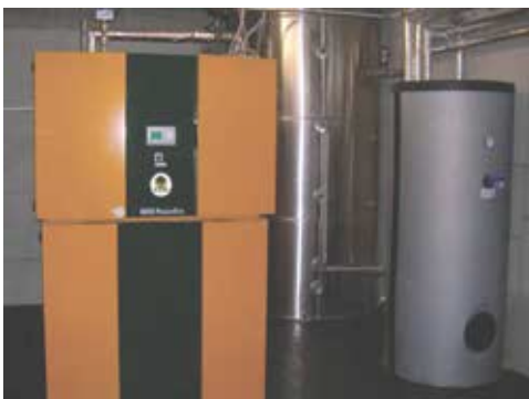
Ogrevalna naprava na sekance (Biomasse Kaiserwald)
