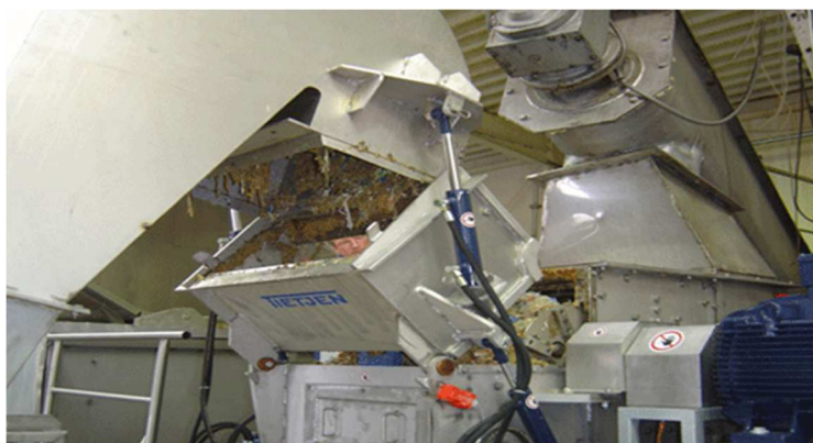
Slika 16: Vizualna kontrola in ročno odstranjevanje motečih materialov iz kuhinjskih odpadkov
